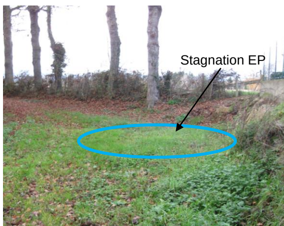
Fig. 26. Stagnation des eaux pluviales – Chemin Malefosse
